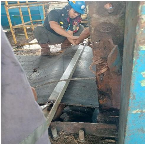
*Gambar 1. Pengencangan Plat Penahan Konveyor*
