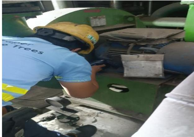
**Gambar 1.** Pengecekan Pompa Menggunakan Vibrasi SKF
