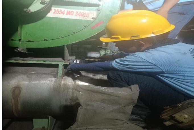
**Gambar 6.** Proses pemasangan pompa setelah di perbaiki
