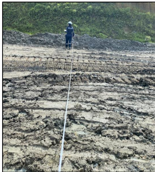
Gambar C.1 Pengukuran Lebar Jalan
