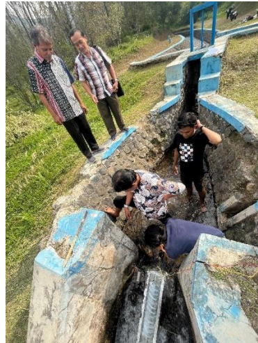
Gambar 5. Pengujian turbine dan generator
