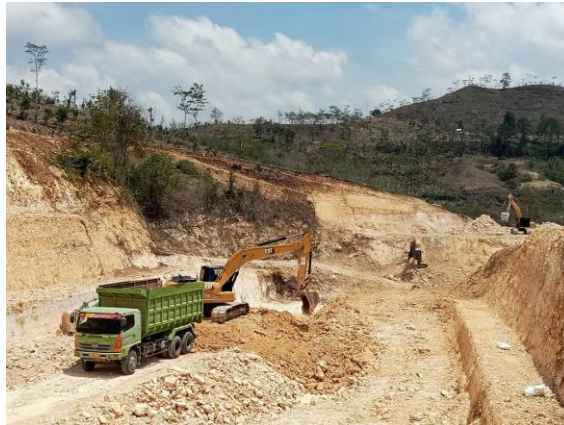
Gambar 1. Pekerjaan Galian STA 13+325 – STA 13+550 Sumber: Data Primer Data Pribadi
