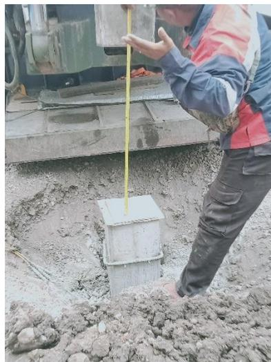
**Gambar 1. 1 Pemukulan Hammer PDA Test**
