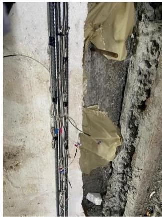
Gambar 3. Pemasangan Sensor Thermocouple
