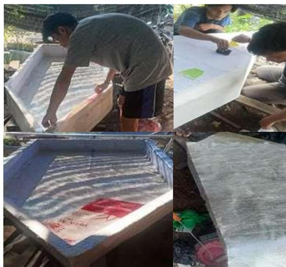
Gambar 4. Pelapisan Dasar Pembuatan Perahu
