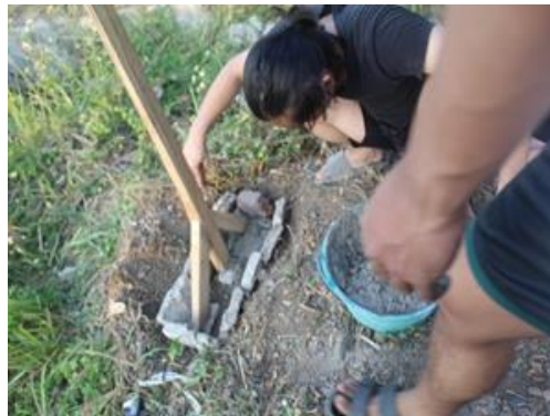
Gambar 8. Pemberian semen pada lubang tanah yang telah terpasang kaki plang pembatas desa
