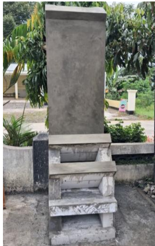
Gambar 2. Insinerator sederhana minim asap yang telah selesai dibuat
